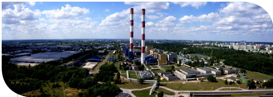
elektrociepłownia EC4 w Łodzi
