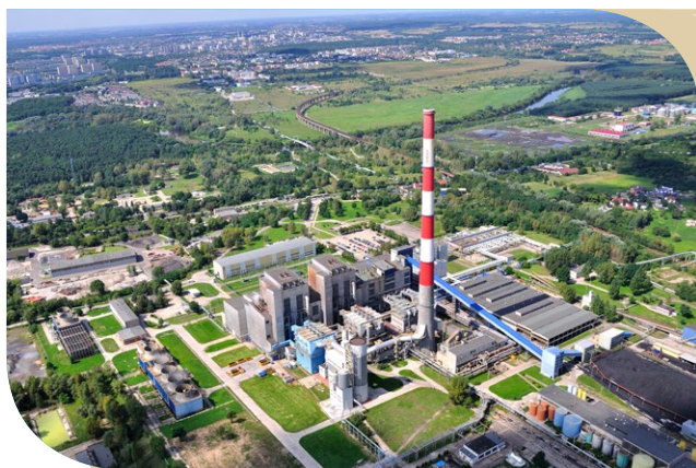
elektrociepłownia EC Karolin w Poznaniu
