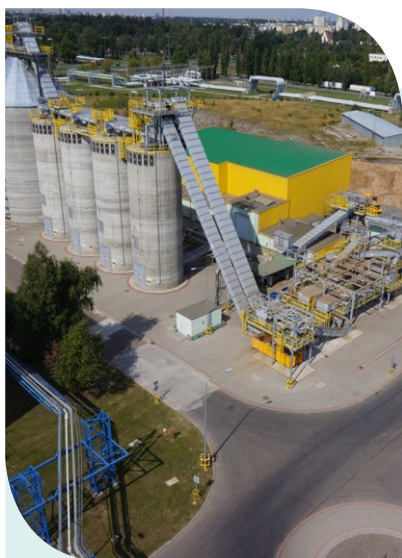
instalacja biomasowa w Łodzi – EC4
